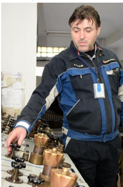
Fig. 5.2 Tabloul de control și distribuție gaze - Laboratorul Hiperbar al Centrului de Scafandri (Arhiva foto a Centrului de Scafandri)
